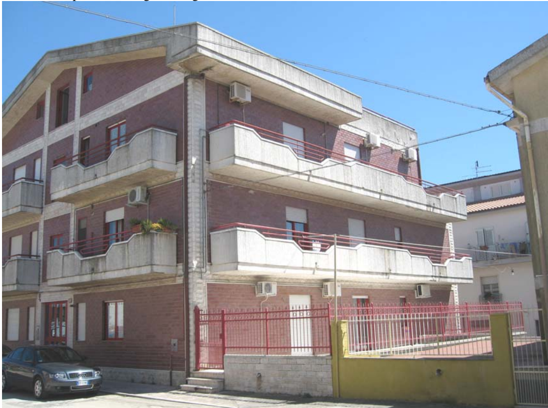
Foto 1 Prospetto Via Magenta, angolo cortile interno
