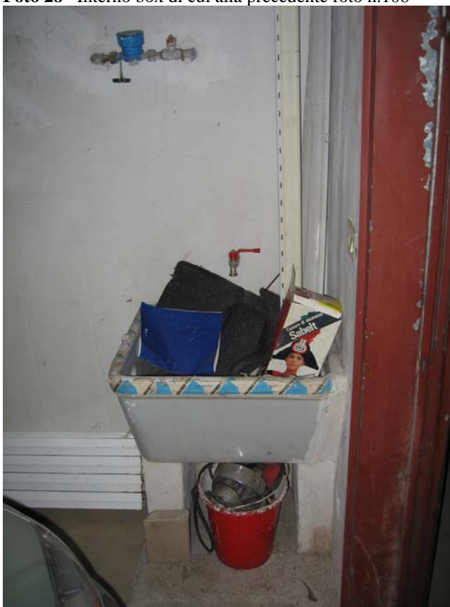
Foto 28 Interno box di cui alla precedente foto n.108
