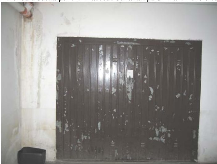
Foto 26 Serranda del box al piano seminterrato, a confine col terrapieno di Via Milano, l'ultimo in fondo a destra per chi vi accede dalla rampa di Via Milano e successiva corsia di manovra
