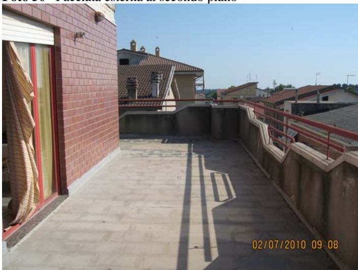
Foto 51 Facciata esterna al secondo piano
