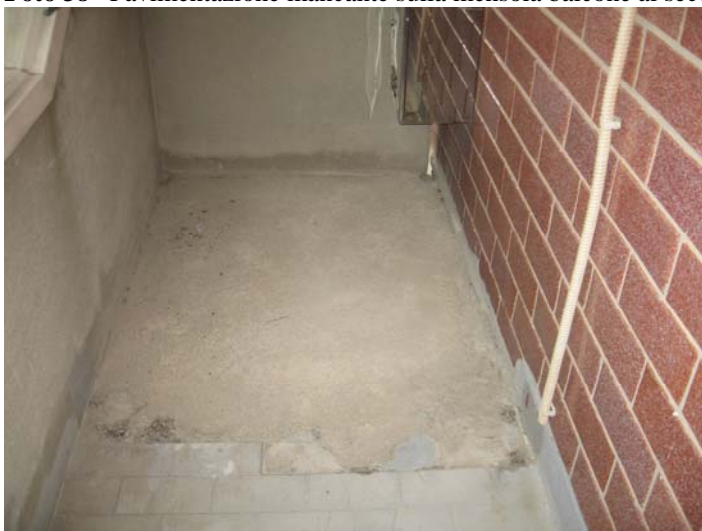
Foto 38 Pavimentazione mancante sulla mensola balcone al secondo piano
