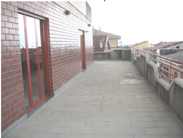
Foto 37 Balcone al secondo piano
