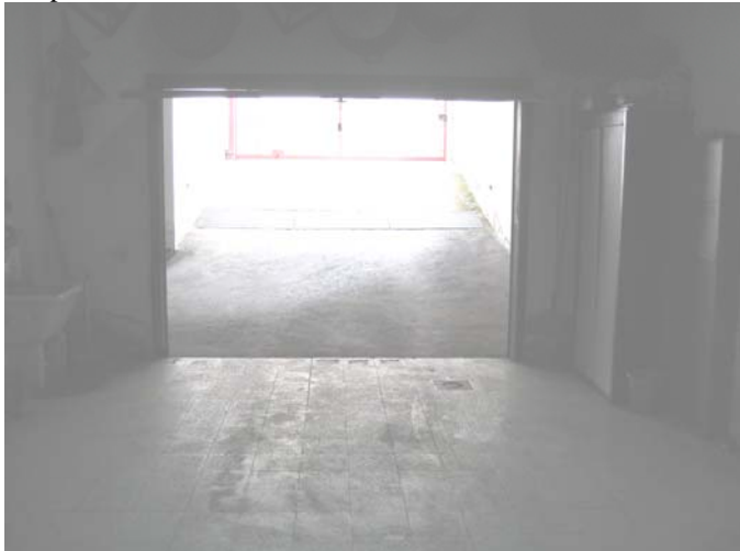
Foto 20 Primo box ad incominciare da sinistra, situato di fronte per chi scende attraverso la rampa carrabile di Via Milano, visto dall'interno verso l'esterno
