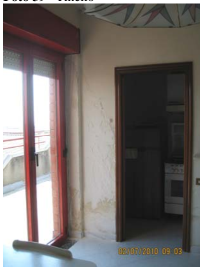
Foto 40 Tinello con rigonfiamento dell'intonaco vicino al radiatore
