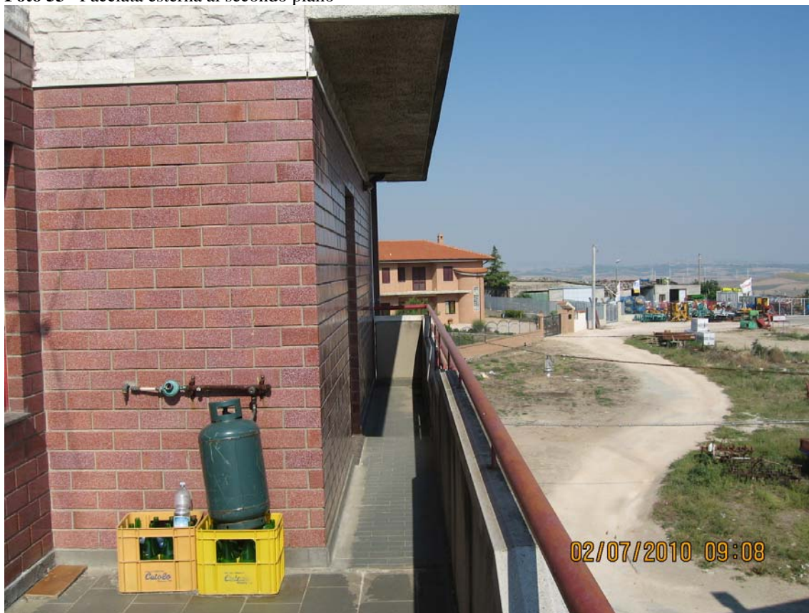
Foto 53 Facciata esterna al secondo piano
