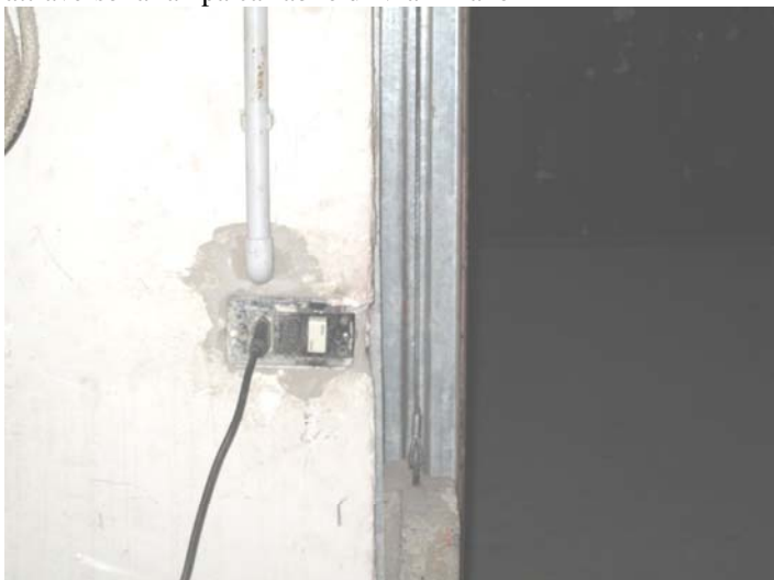
Foto 19 Interno del secondo box ad incominciare da sinistra, situato di fronte per chi scende attraverso la rampa carrabile di Via Milano
