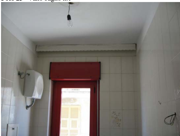
Foto 23 Vano bagno n.1
