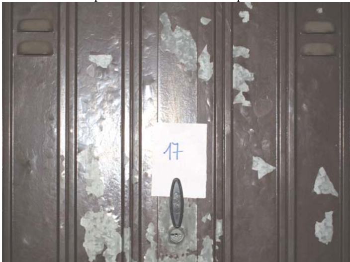
Foto 25 Serranda del box al piano seminterrato, a confine col terrapieno di Via Milano, l'ultimo in fondo a destra per chi vi accede dalla rampa di Via Milano e successiva corsia di manovra
