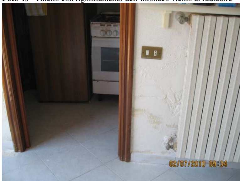
Foto 40 Tinello con rigonfiamento dell'intonaco vicino al radiatore
