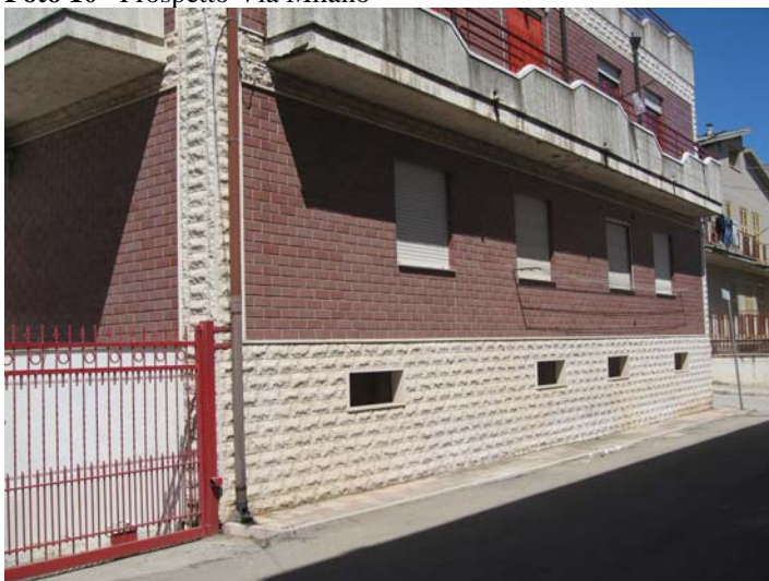
Foto 10 Prospetto Via Milano
