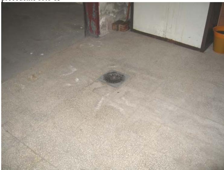
Foto 21 Pavimentazione in riquadri commerciali esistente all'interno del primo box di cui alla precedente foto 65
