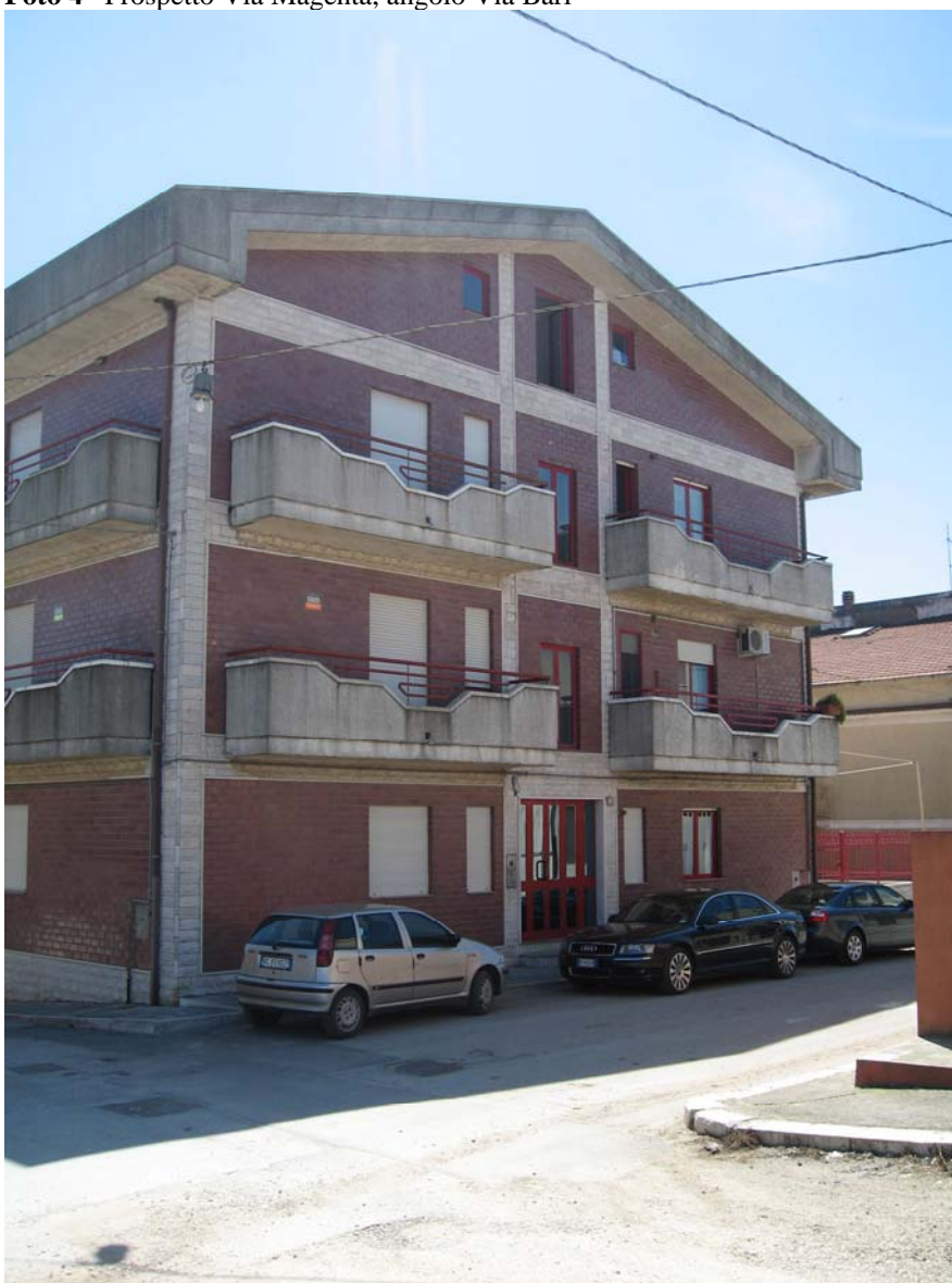
Foto 4 Prospetto Via Magenta, angolo Via Bari
