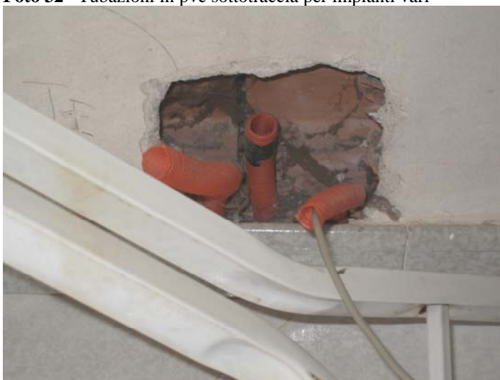
Foto 32 Tubazioni in pvc sottotraccia per impianti vari
