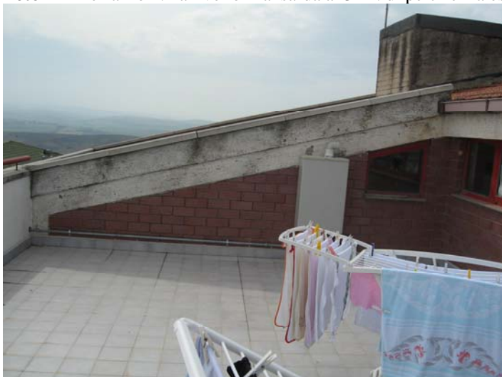
Foto 21 Terrazzo n.2 a livello Mansarda al 3° P. di pertinenza esclusiva
