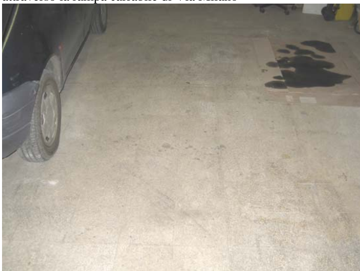
Foto 20 Interno del secondo box ad incominciare da sinistra, situato di fronte per chi scende attraverso la rampa carrabile di Via Milano
