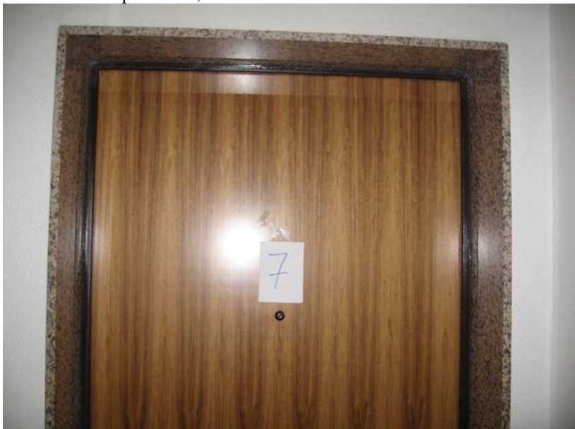
Foto 25 Porta padronale, lato esterno
