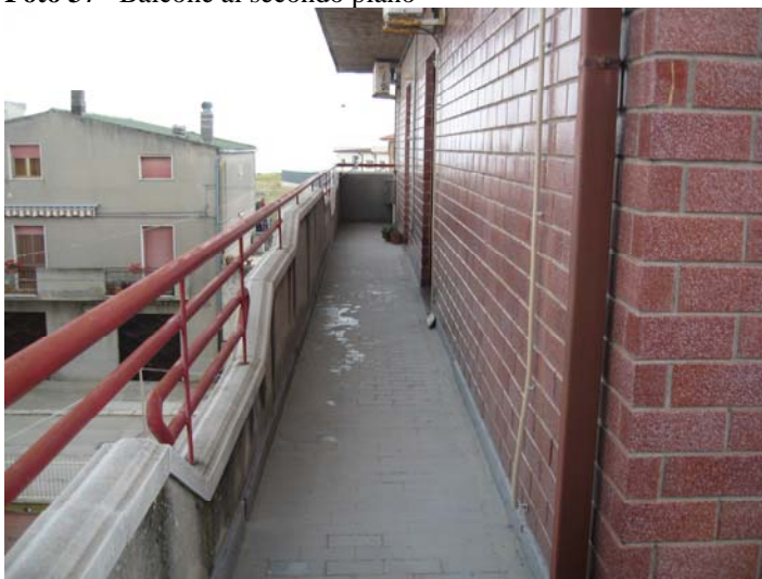
Foto 38 Pavimentazione mancante sulla mensola balcone al secondo piano
