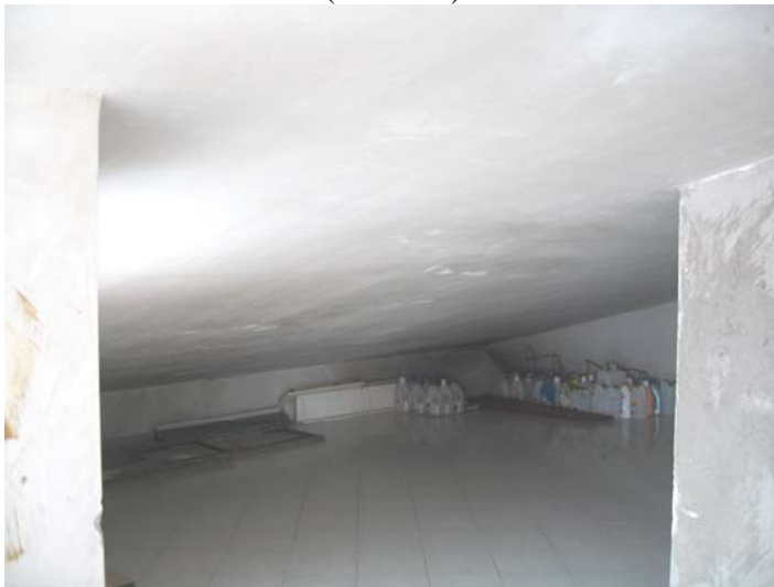
Foto 29 Locale sottotetto (Mansarda) al 3° P.
