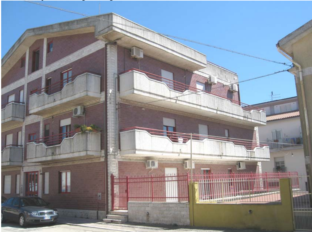
Foto 1 Prospetto Via Magenta, angolo cortile interno
