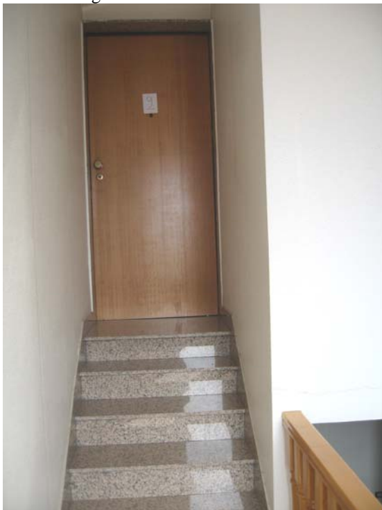
Foto 14 Ingresso al sottotetto attraverso il vano scala condominiale
