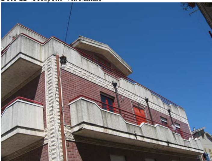
Foto 11 Prospetto Via Milano
