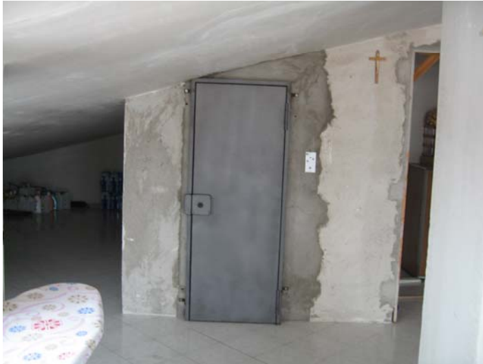
Foto 28 Vano ascensore con accesso esclusivo a livello mansarda al 3° P.
