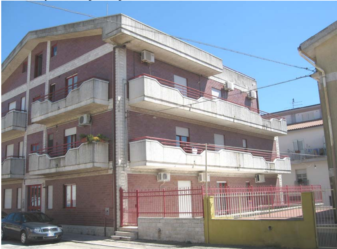
Foto 1 Prospetto Via Magenta, angolo cortile interno
