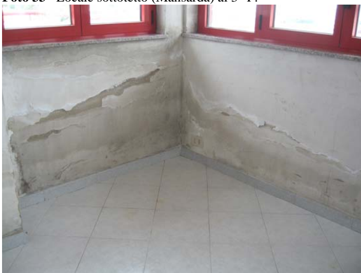
Foto 33 Locale sottotetto (Mansarda) al 3° P.
