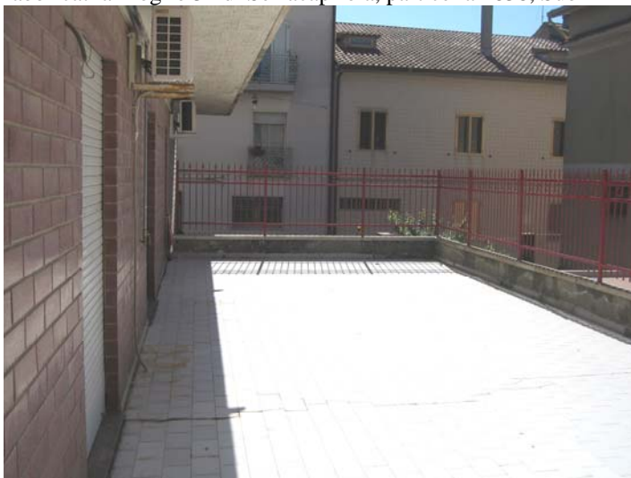
Foto 2 Cortile interno al piano terra, annesso e connesso all'appartamento distinto in catasto fabbricati al Foglio 34 di Serracapriola, particella 1838, Sub 2
